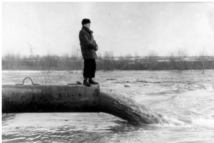
Рис. 1. Процесс транспортировки золы на Прибалтийской ГРЭС.
