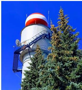
Рисунок 2. ДМРЛ-С Уфа, установленный на крыше водонапорной башни.
