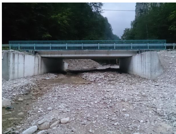
Рис. 4. Мост в устьевой части р. Ушхар суу.
